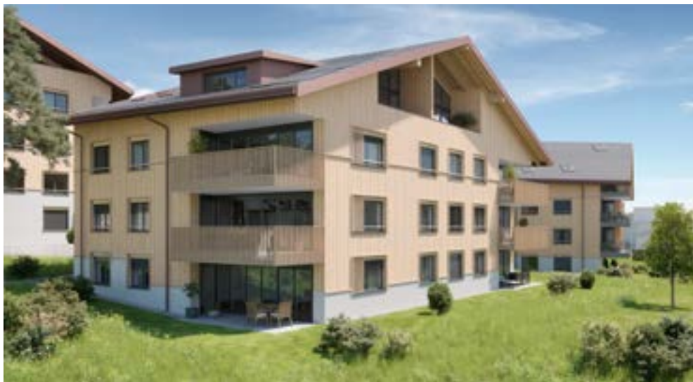
Die Häuser werden mit Fotovoltaikflächen und Pelletheizungen ausgerüstet.
